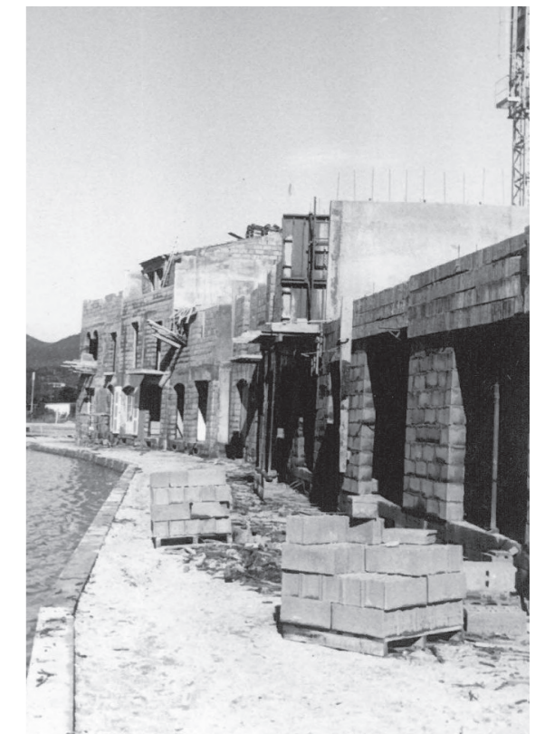
Photographie du montage des murs des maisons de la première tranche, 1967 Source : Archives de l'Atelier Xavier Bohl
