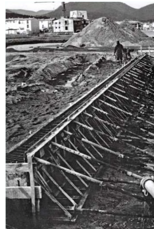
Photographie de l'enfouissement des palplanches, 1966 Source : Archives de l'Atelier Xavier Bohl
