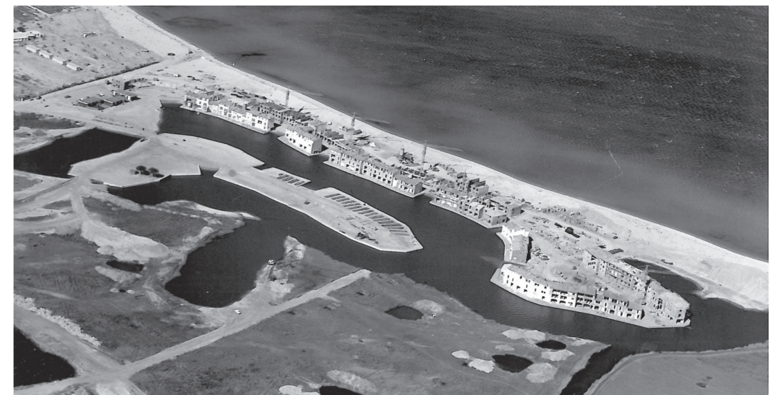
Photographie aérienne de la première tranche en construction, 22 avril 1967 Source : Archives de l'Atelier Xavier Bohl
