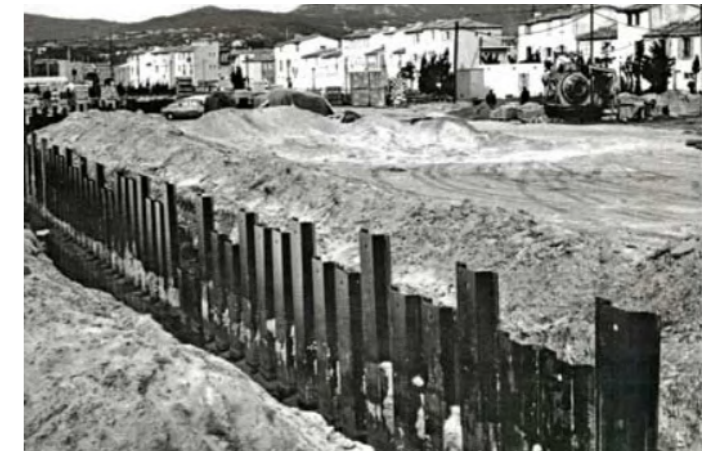
Photographie des palplanches installées, 1966 Source : Archives de l'Atelier Xavier Bohl
