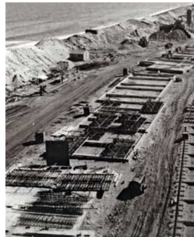
Photographie des fondations des bâtiments de la première tranche, 1967 Source : Archives de l'Atelier Xavier Bohl
