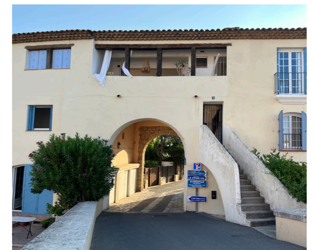
Porte séparant la Place du Marché de la rue de l'Octogone, 2022 Source : Photographie personnelle
