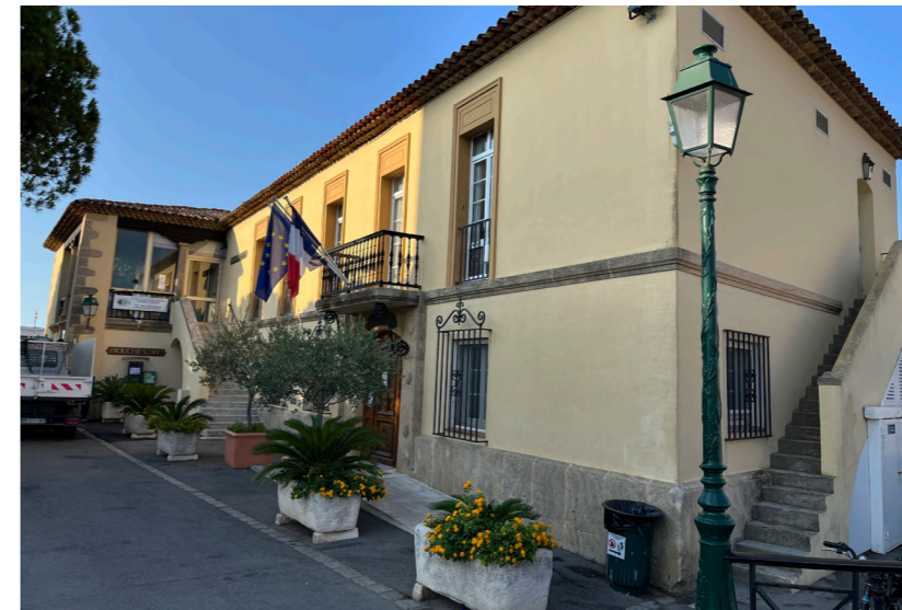
Maison commune aux ferronneries d'inspiration andalouse et dont la façade nord rappelle l'architecture vénitienne, 2022 Source : Photographie personnelle
