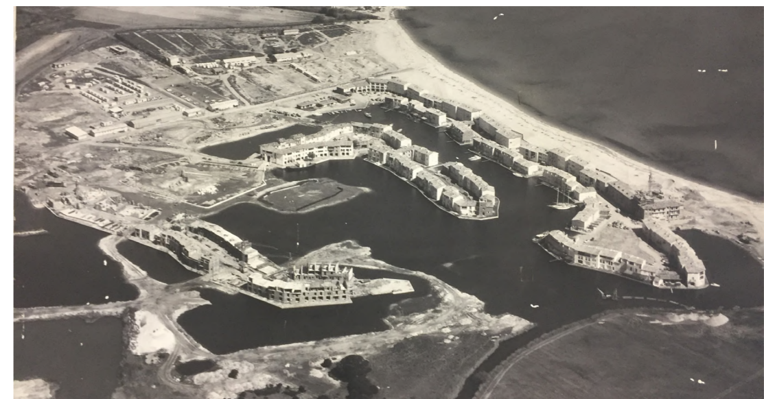
Photographie aérienne de la construction de la troisième tranche, 1968 Source : Archives de l'Atelier Xavier Bohl
