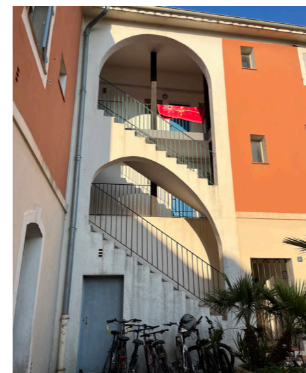
Cage d'escalier avec colonnade de bois d'inspiration provençale Source : Photographie personnelle
