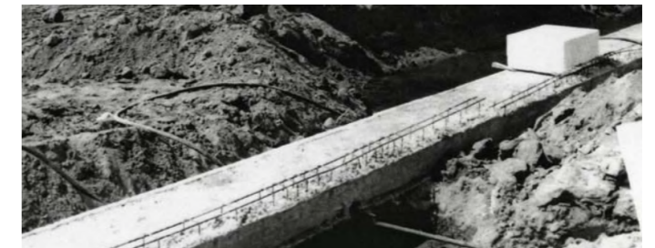
Photographie des pierres des quais sur les couronnements en béton, 1966 Source : Archives de l'Atelier Xavier Bohl
