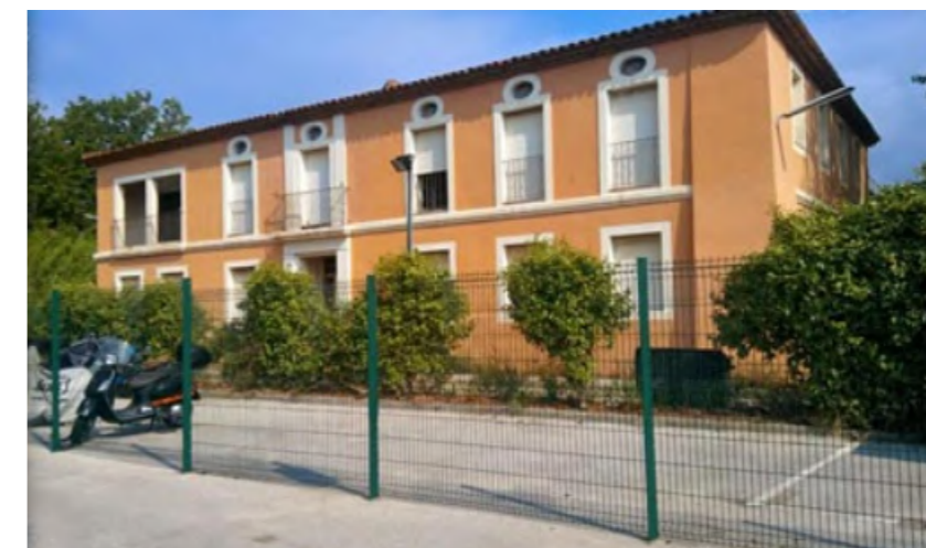
Photographie du central téléphonique à Port Grimaud II Source : port-grimaud.org
