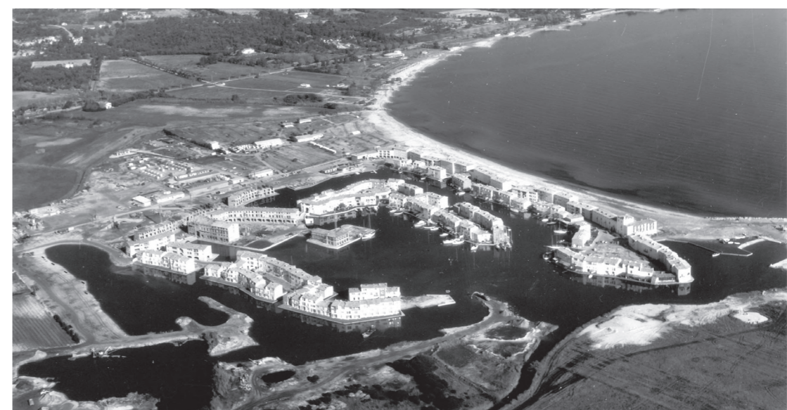
Photographie aérienne de la construction de la cinquième tranche, 1968 Source : Archives de l'Atelier Xavier Bohl
