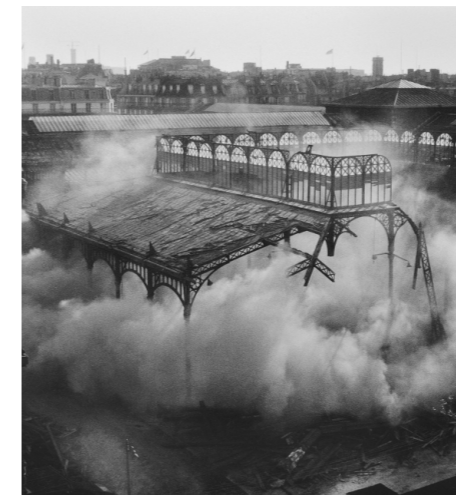
Destruction des Halles de Baltard, Paris, de 1971 à 1973.
